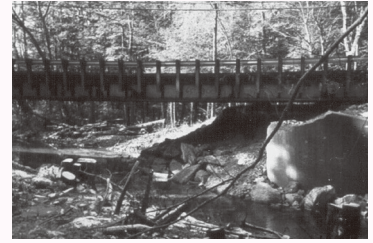
圖 13-56 賓州中部的一座橋梁。1996 年的一次 50 年洪水在橋的基礎附近所造成的挖蝕。在一座新橋被設計期間，一座暫時的金屬橋被放置在這個開口上。
